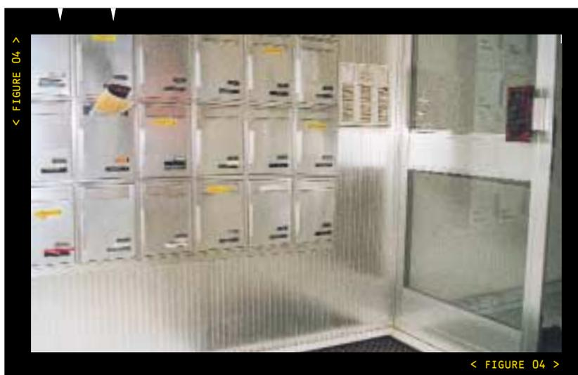
**Figure 04** boîtes accessibles à partir d'un fauteuil roulant
