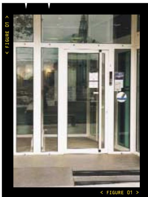
**Figure 01** local non accessible aux personnes en fauteuil roulant; le dispositif d'ouverture de la porte est hors d'atteinte
