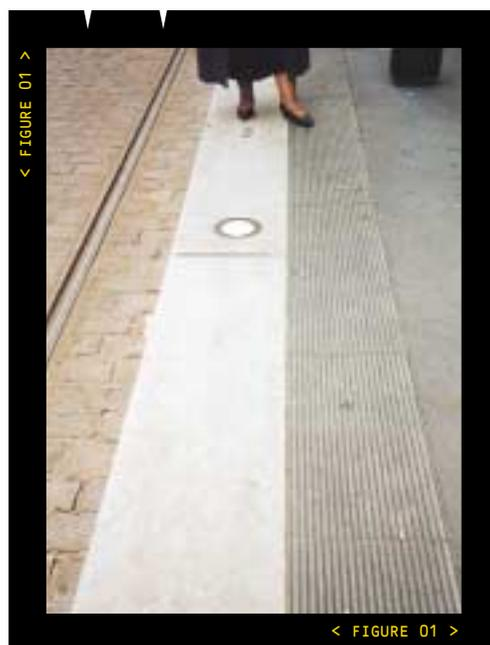
**Figure 01** repérage tactile au niveau des quais
